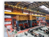
ЧЕЛЯБИНСКИЙ ТРУБОПРОКАТНЫЙ ЗАВОД
